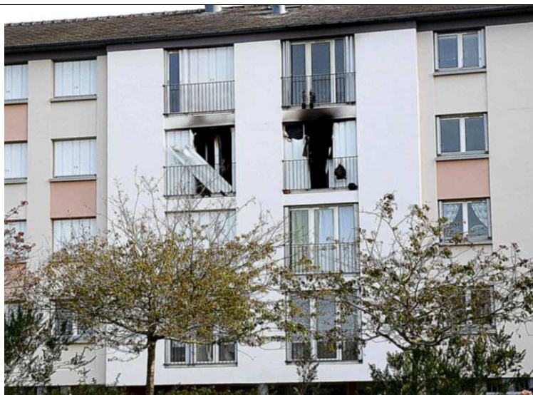
Le feu aurait pris dans la chambre du logement situé au troisième étage d'un des immeubles de la rue de Flandres, à Lannion.
